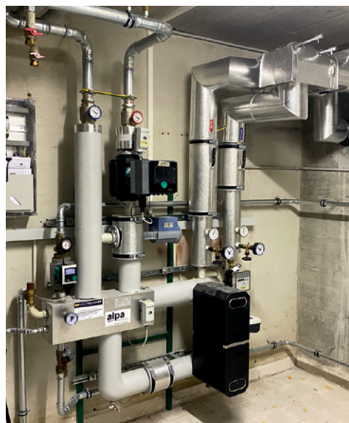
Échangeur thermique dans un bâtiment relié au thermorezo.
